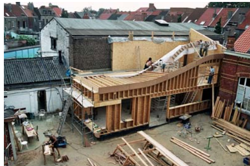
Gebouw in opbouw, bron: PHPvzw, foto: Kobe Wens
